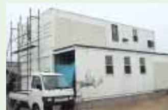
リサイクルコンテナで家屋を建築
