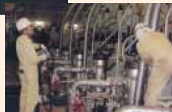
発電機のメンテナンス
