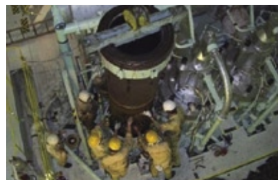
機関部：ピストン抜き作業風景
