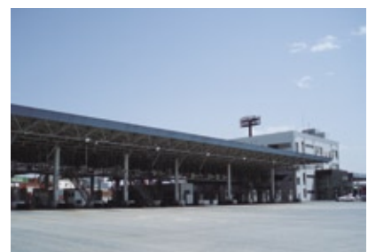
東京国際コンテナターミナル 4号バースゲート棟
