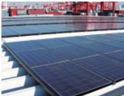
しました。ターミナル内のゲート棟・洗車棟の屋上に太陽光発電パネル1,200枚を設置、民間施設では都内最大規模となる約200キロワットの発電容量は、一般家庭約60世帯分の年間電力使用量に相当します。
