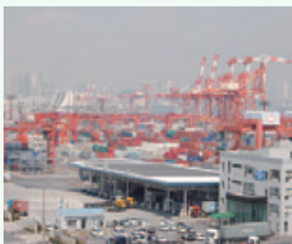
東京国際コンテナターミナル
