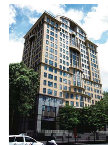
サイゴン・タワー
