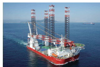
発電設備設置 (SEP船)
