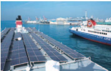
太陽光発電システム
