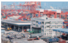
東京国際コンテナターミナル
