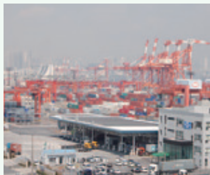
東京国際コンテナターミナル
