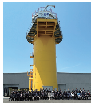
洋上風力発電の運用・保守管理トレーニング設備
