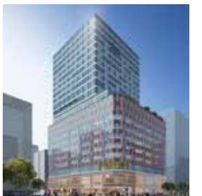
札幌ダイビル外観(完成イメージ)
