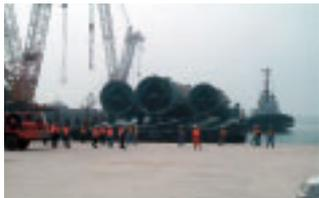
上:中国・惠州のエチレンプラント建設現場に外洋バージで運ばれた数百トン級の蒸留塔
