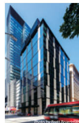
豪州初進出オフィスビル [275 George Street]
